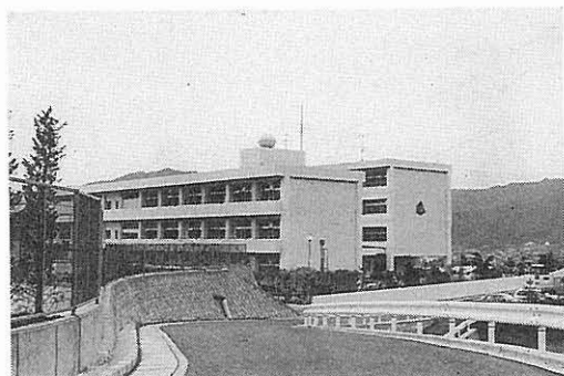
図6-4-28 熊野東中学校の写真
